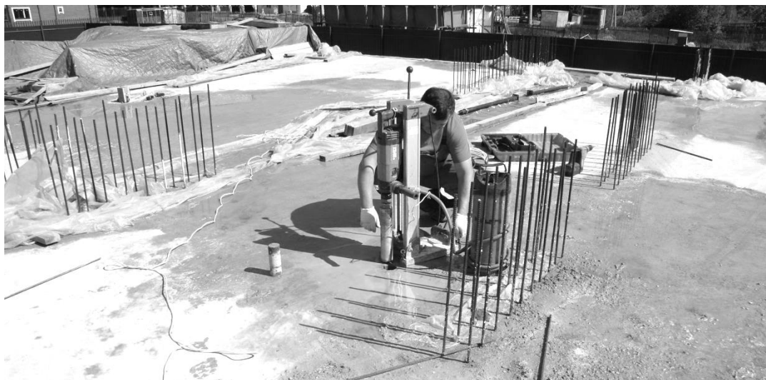
Рис. 12.1. Выбуривание пробы бетона при помощи бурильной установки HILTI
