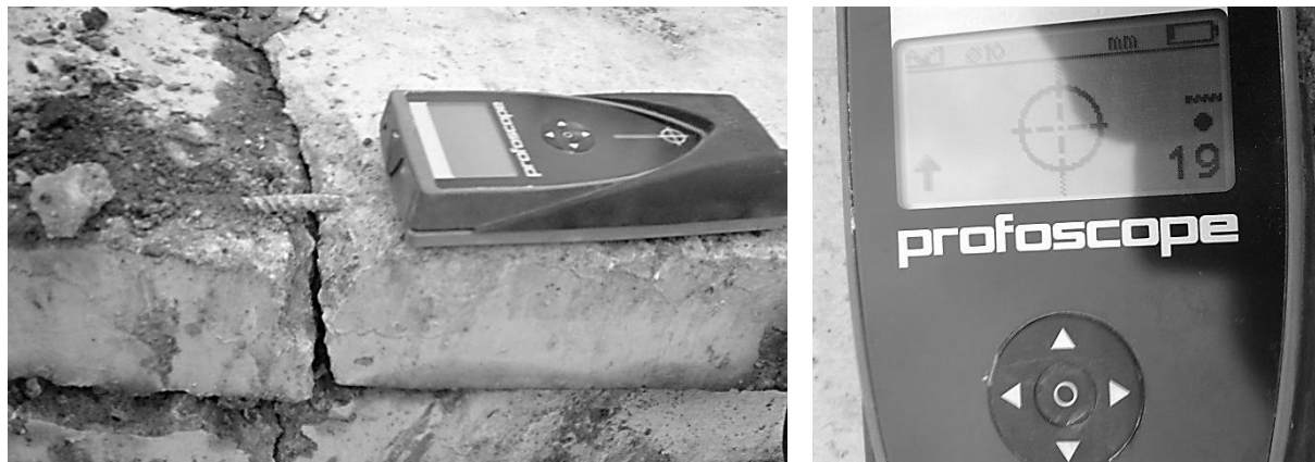
Рис. 11.6. Поиск арматуры при помощи прибора «Profoscope»
